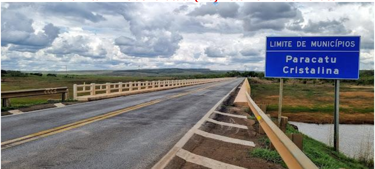
BR - 040. A caminho de Paracatu (MG). Ponte sobre Rio São Marcos. Divisa GO/MG. Foto: Fernando Mendes.
