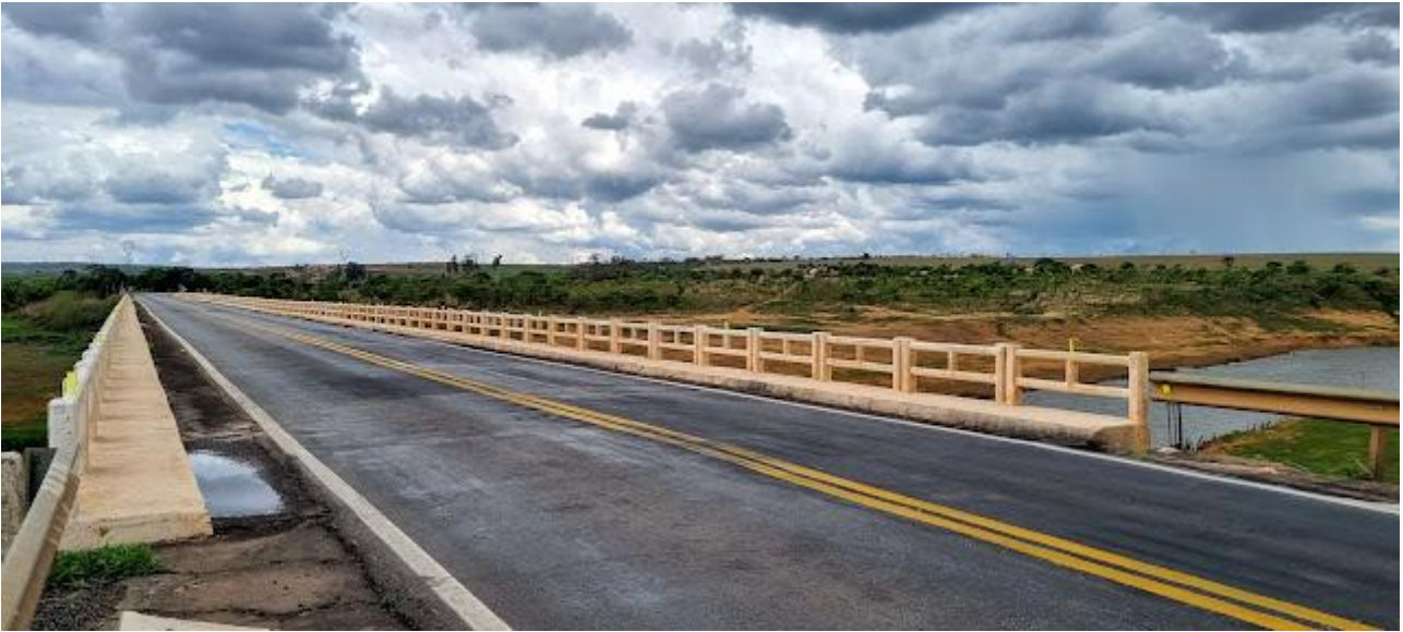
Ponte sobre Rio São Marcos. Foto: Fernando Mendes.
